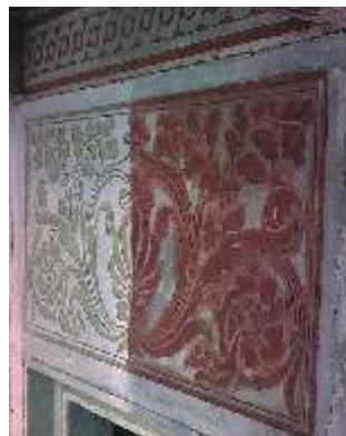
Particolare dell'intonaco a graffito durante la rimozione delle ridipinture
