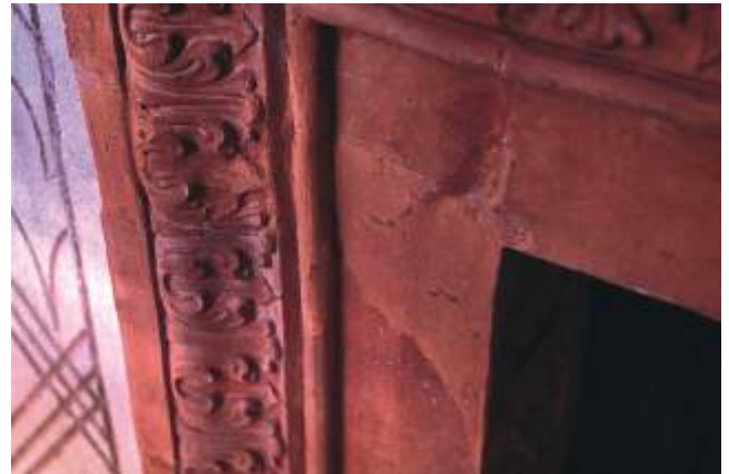
Particolare di una formella in cotto modellato prima e dopo il restauro
