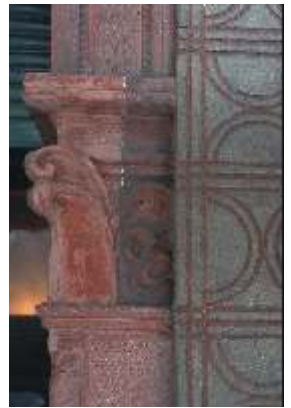
Particolare di un pilastro durante la campionatura
