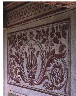
Particolare dell'intonaco a graffito a restauro ultimato
