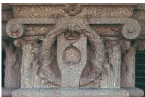
Particolare di un capitello in cemento decorativo prima e dopo il restauro
