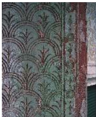
Particolare dell'intonaco a graffito prima e dopo il restauro
