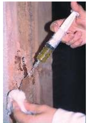
Particolare di una formella in cotto modellato durante il consolidamento
