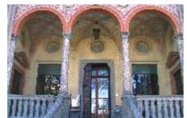
Veduta generale del portichetto ad intervento ultimato
