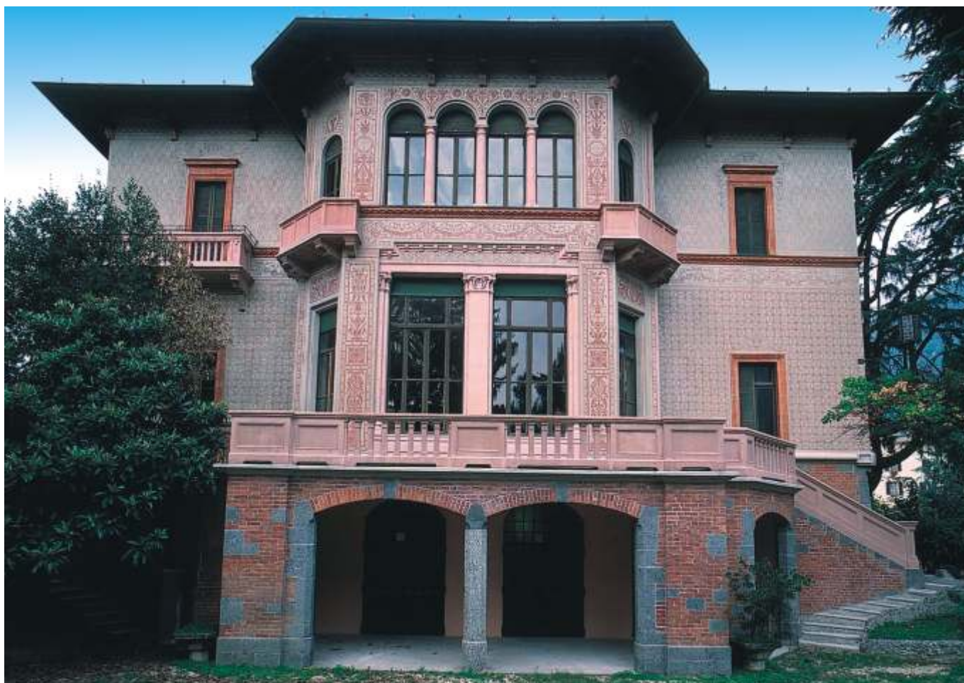
Fronte Est, veduta generale dopo l'intervento
